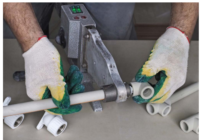
Abb. 34 Heißschweißen von PVC-Rohren
