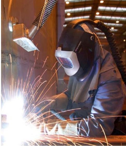
Abb. 8 Schweißrauchabsaugung plus Schweißerschutzhaube mit Frischluftversorgung (persönliche Schutzausrüstung)
