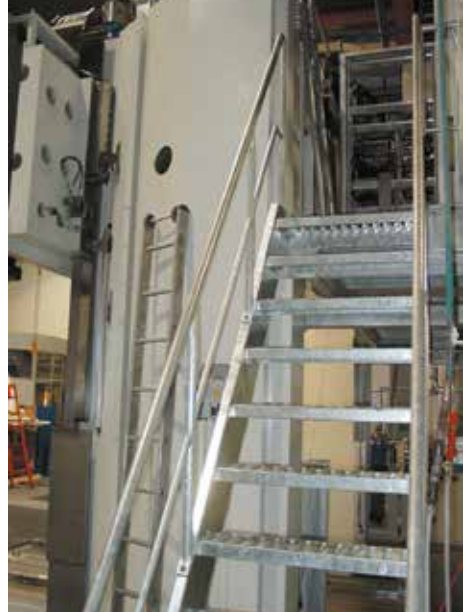
Bild 2-54: Treppe zur Schaltschrankbühne eines großen Bearbeitungszentrums
