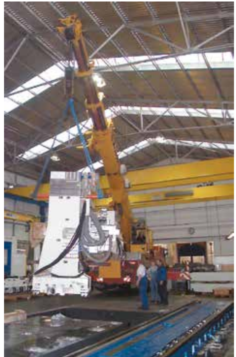
Bild 2-9: Maschine im Autokran
