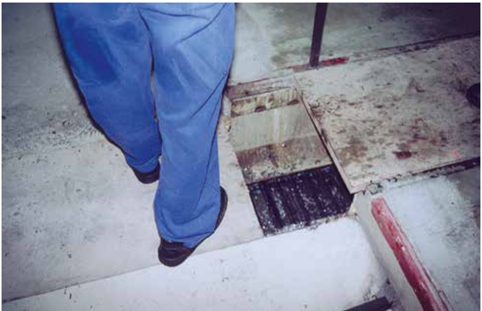
Bild 2-58: Unvollständig abgedeckter Späneförderer
