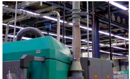
Abb. 37 Anschlussstück zur Vibrationsentkopplung; senkrecht, geerdet
