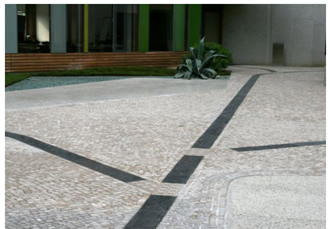
Abb. 2 Einsatz von Bodenindikatoren
