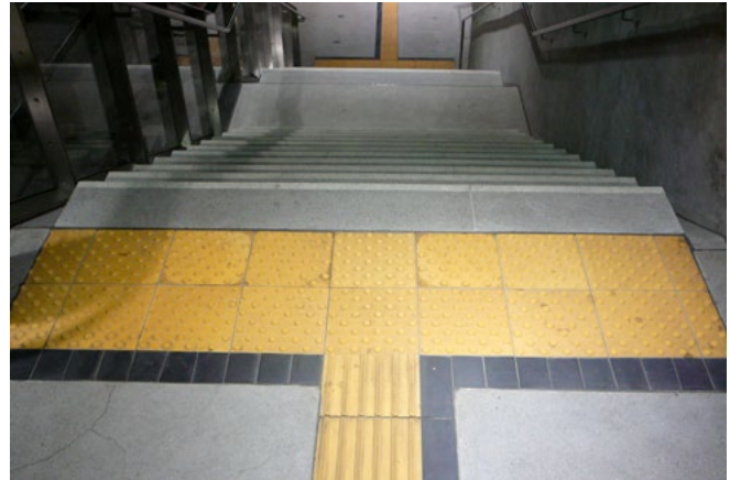
Abb. 11 Hinweis auf Gefahrenstelle
