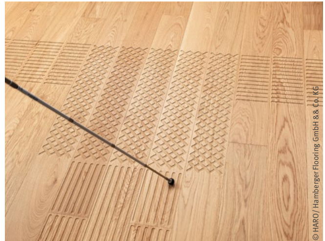
Abb. 10 Bodenindikatoren am Beispiel eingefräster Muster
