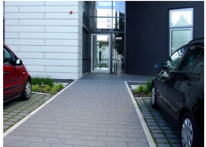
Abb. 3 Taktile und visuell kontrastreiche Begrenzung
