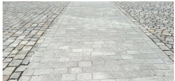
Abb. 5 Bearbeitetes Natursteinpflaster
