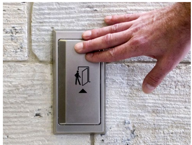
Abb. 11 Großflächiger Kippschalter
