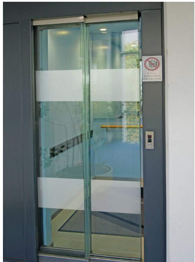
Abb. 1 Aufzug mit Markierungen auf Glasflächen
