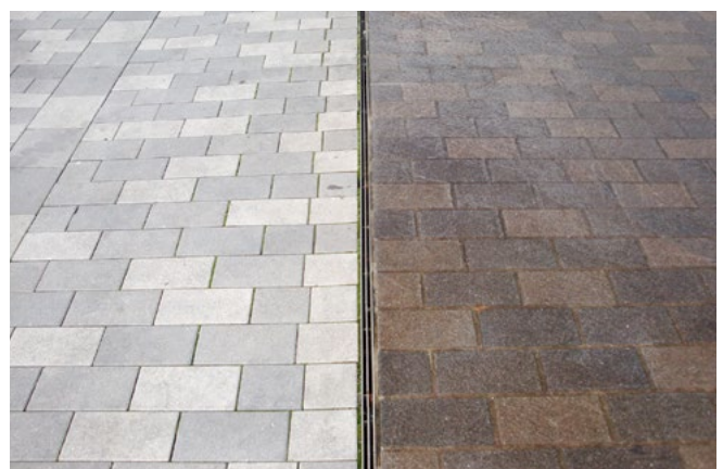
Abb. 10 Änderung von Farbe und Helligkeit durch Feuchtigkeit
