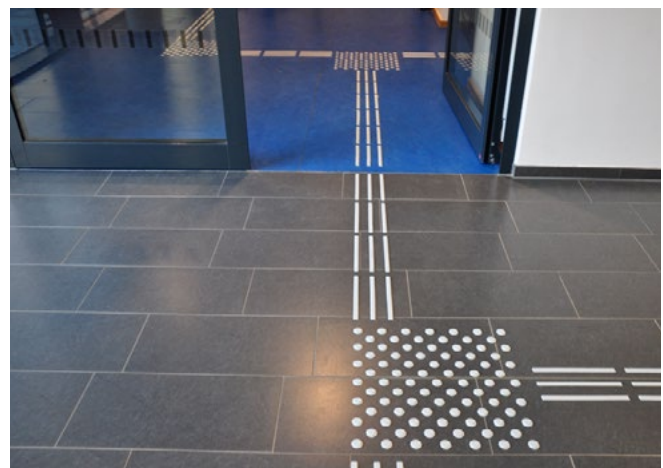
Abb. 9 Bodenindikatoren am Beispiel aufgeklebter Rippen und Noppen
