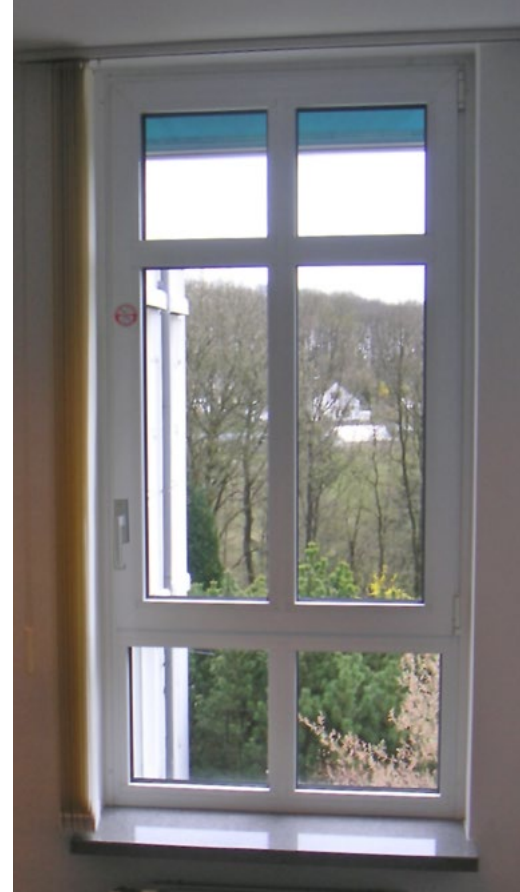
Abb. 1 Fenster mit Unterlicht
