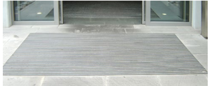
Abb. 3 Stufen- und Schwellenfreier Eingang
