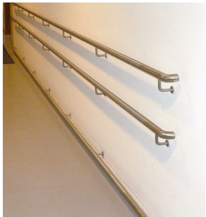
Abb. 6 Horizontale Handläufe
