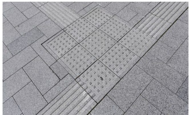
Abb. 10 Rippenstruktur zur Längsorientierung, Abzweigungsfeld in Noppenstruktur
