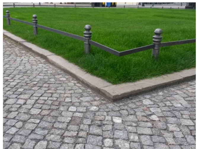
Abb. 6 Verkehrsflächenabgrenzung durch markante Aufkantung
