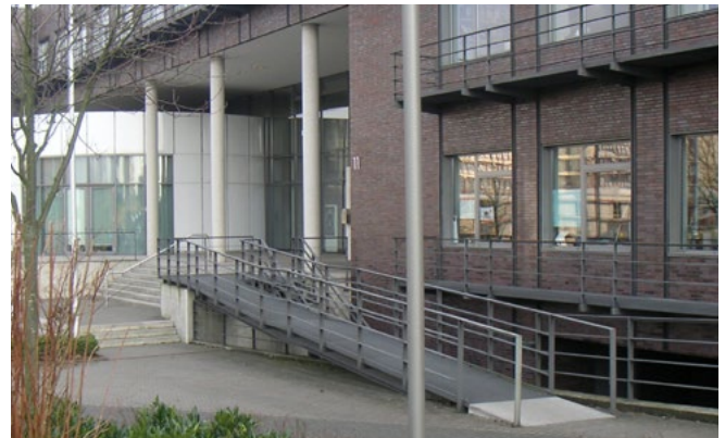
Abb. 4 Rampe im Außenbereich mit Gitterrostbelag
