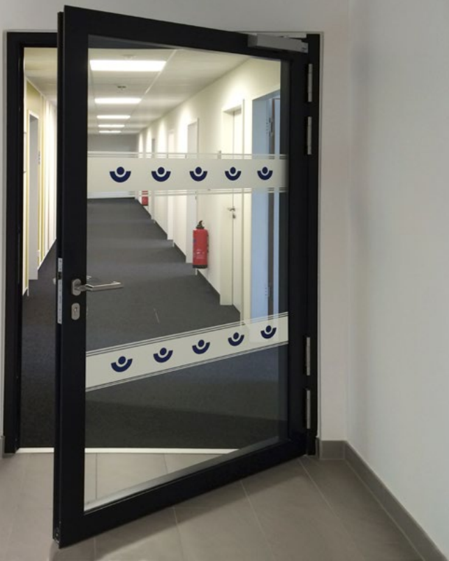
Abb. 2 Visuell kontrastreiche Gestaltung durch helle Wand und dunkle Türkonstruktion
