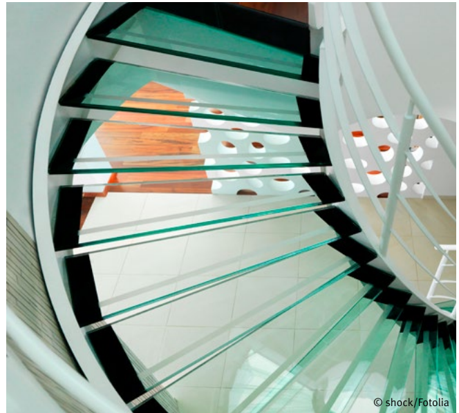
Abb. 3 Unsicherheit aufgrund durchsichtiger Bodenbeläge
