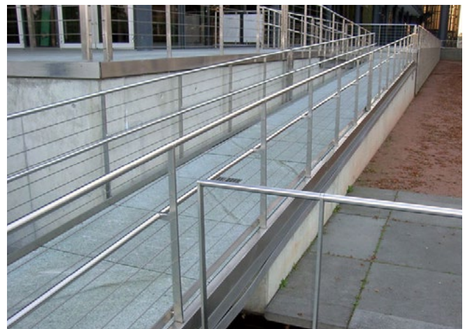
Abb. 7 Rampe im Außenbereich mit Betonplattenbelag
