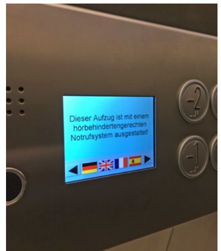
Abb. 10 Notrufsystem nach dem Zwei-Sinne- bzw. Zwei-Kanal-Prinzip
