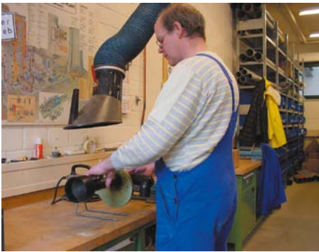
Abb. 11 Heißschweißen von PVC-Rohren
