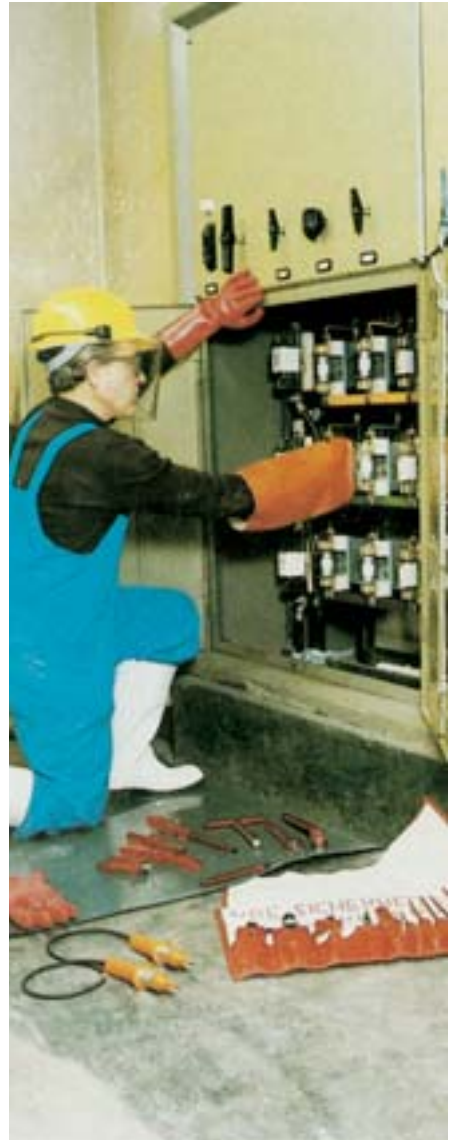
Bild 14-1: Arbeiten unter Spannung
