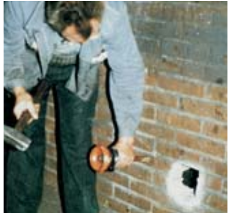
Bild 3-6: Bei Stemmarbeiten am Mauerwerk müssen Handschutz und Schutzbrille benutzt werden
