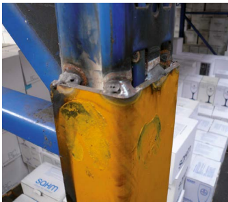
Abb. 11 Unfachmännisch geschweißte Stütze
