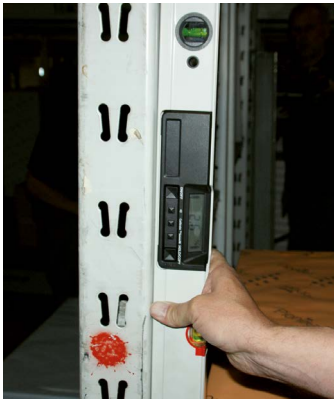
Abb. 10 Messung der Schiefstellung mit digitaler Wasserwaage
