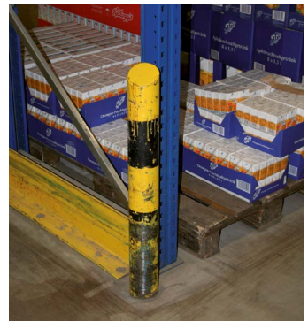
Abb. 14 Besonders stabil ausgeführter Anfahrtschutz
