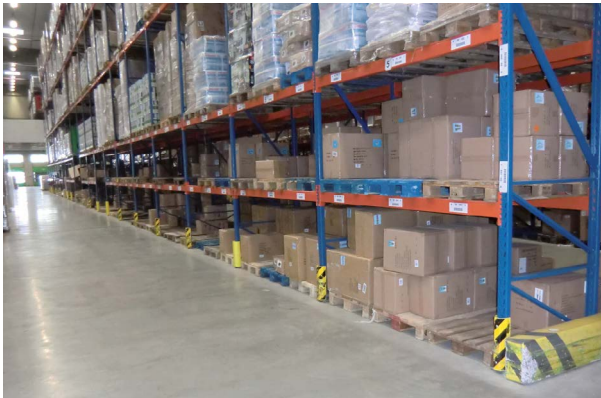
Abb. 19 Stützenschutz an allen Stützen
