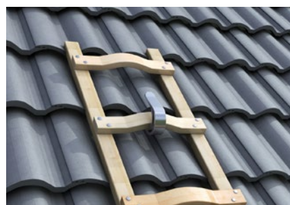
Abb. 66 Einhängen der Dachauflegeleiter
