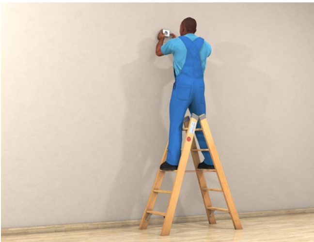
Abb. 56 Sicherer Stand auf einer beidseitig begehbaren Stufenstehtleiter
