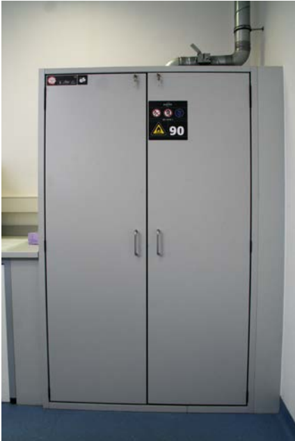
Abb. 17 Lagerung entzündbarer Flüssigkeiten im Sicherheits-schrank (explosionsgeschützte Lagerung)
