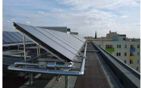
Abb. 4 Solarthermie-Anlage
