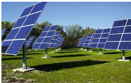
Abb. 9 Module auf Freiflächen können starr am Boden befestigt in eine Richtung ausgerichtet, oder an ein bewegliches Gestellsystem montiert sein und dann dem Sonnenstand nachgeführt werden. Freiflächenanlagen sind in der Regel durch Zaunanlagen vor unbefugtem Zugriff geschützt.
