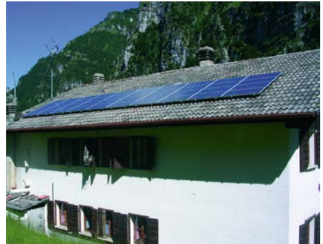
Abb. 13 Hier versorgt das Photovoltaik-System eine Hütte mit elektrischer Energie. Dabei ist von außen nicht erkennbar, ob es sich im Gebäude um ein reines Gleichstromnetz handelt oder ein Wechselrichter eingesetzt wird.
