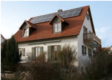
Abb. 6 PV-Anlage auf einem freistehenden Gebäude.
