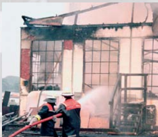
Einsturzgefahr der Fassade durch Brandeinwirkung
