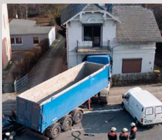
Einsturz einer Hauswand durch äußere Schadenseinwirkung
