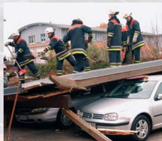
Einsturz durch Überlastung der Carport-Konstruktion
