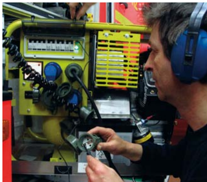
Überprüfung der Schutzmaßnahme eines tragbaren Stromerzeugers
