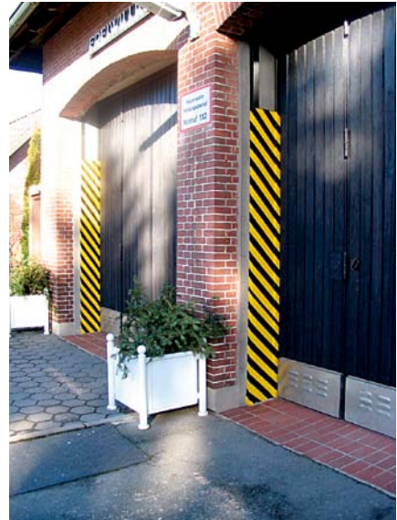
Gelb-schwarze Gefahrenkennzeichnung der Tordurchfahrt nach außen
