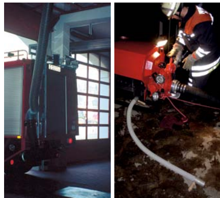
Der Abgasschlauch trennt sich automatisch unmittelbar vor der Ausfahrt ins Freie.
