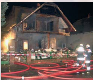
Fassadeneinsturz nach Explosion
