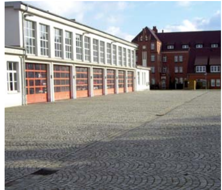
Der Stauraum vor den Toren bringt Sicherheit.
