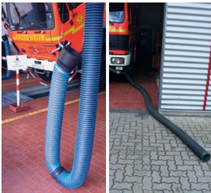
Abgasabsaugung im Werkstattbereich
