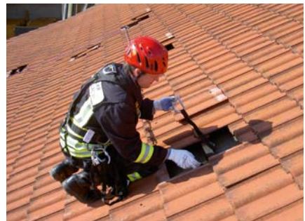
Arbeiten auf Dächern
