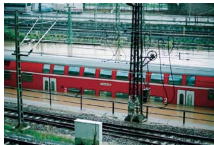
Durch den Anlagenbetreiber abgeschaltete Hochspannungsanlagen der Bahn nach Überflutung der Bahntrasse
