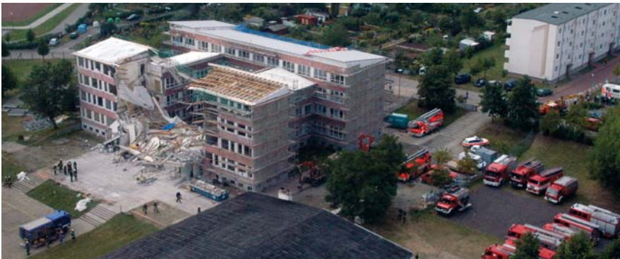
Einsturz eines Schulgebäudes durch unsachgemäße Bauarbeiten
