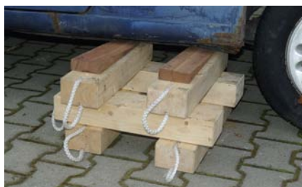
Unterbau durch Rüsthölzer
